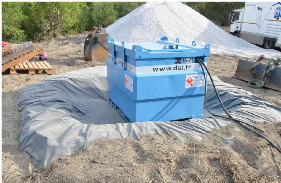
☞ Photographie 7 : Mise en place d'une aire étanche autour d'un groupe électrogène
